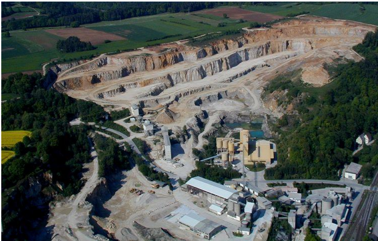
Luftbild Sebald Zement, Quelle: Sebald Zement
